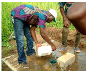
Desinfection du forage...
