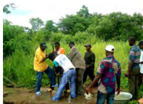
Mise en place de la pompe.
