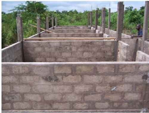
Construction de la porcherie de Kpédiké : 15 x 5 m - 5 loges
